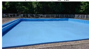
塗装剥がれ、コンクリート破損の修繕と色の塗り替え
