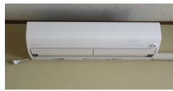
全教室にエアコン設置
