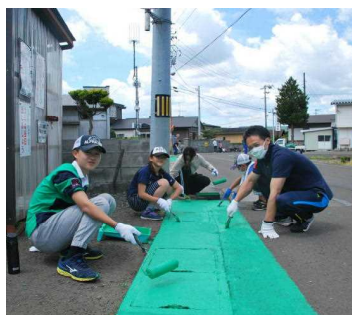
グリーンベルト塗装作業
